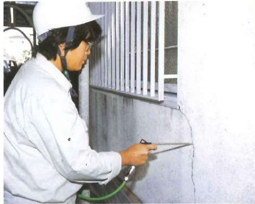
亀裂内部の高圧洗浄
