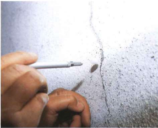
亀裂深さの測定
