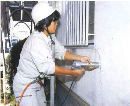
エポソフトグラウトの注入作業
