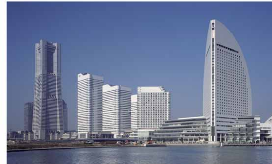
ランドマークタワー・プラザ(左)【 sc-MS 2NB/SUPER II SC-500, UH-30 sc-SR 2 】 クイーンズスクエア横浜(中央)【 sc-MS 2NB/SUPER II SC-500, UH-30 sc-SR 2 】 ヨコハマグランドインターコンチネンタルホテル(右)【 sc-MS 2NB/SUPER II 】
