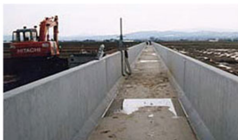
北海道 (国附かん排深川第2地区21工区)
