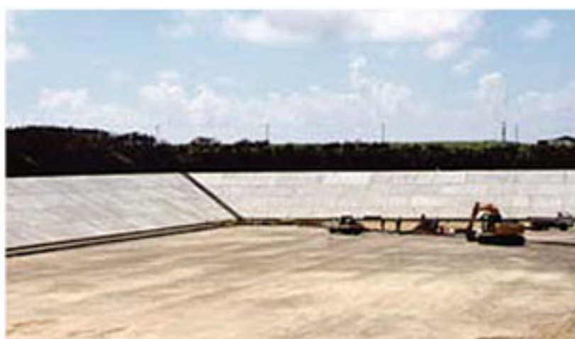
沖縄県 (波照間地区貯水池建設工事)
