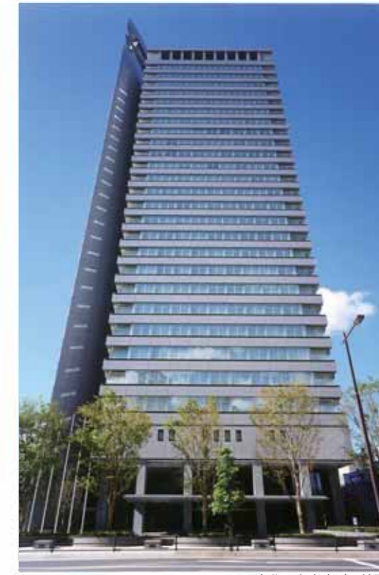
東北電力本店ビル外壁 【 sc-MS 2NB/SUPER II 】
